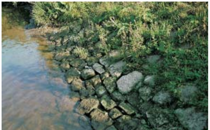
Bild rechts: Gepflastertes Mainufer vor 1996
