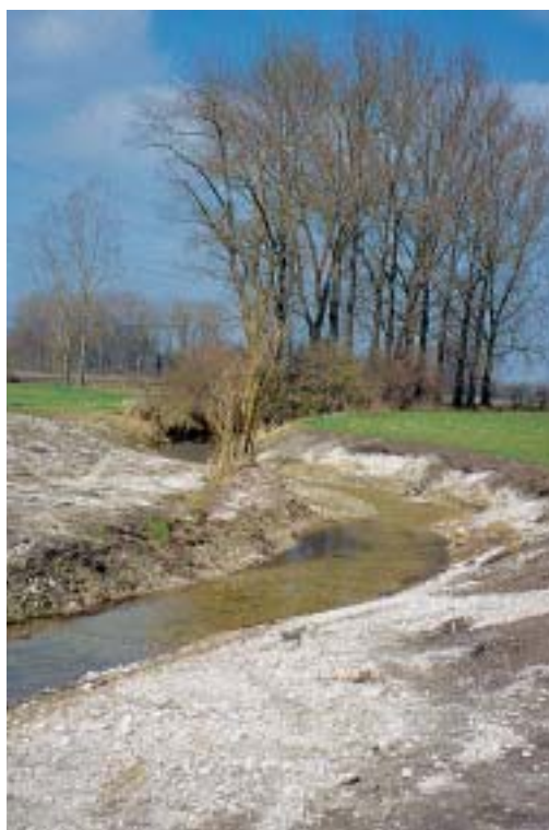
Nach der Renaturierung: Noch fehlen Ufergehölze. Bis sie aufwachsen und Totholz liefern, sollten Totholzstrukturen eingebaut werden.
