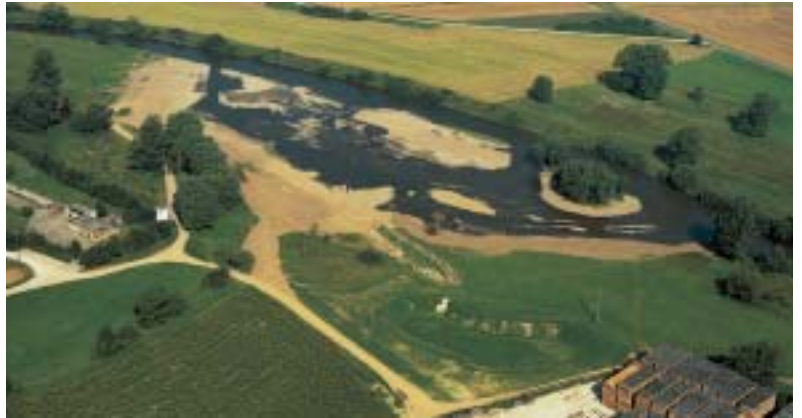
Umgestalteter Mainabschnitt bei Ebensfeld (1995).
